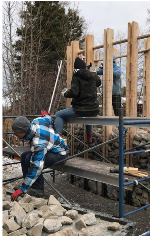
Figure B-10. Travail à la chaîne pour le remplissage du cœur
