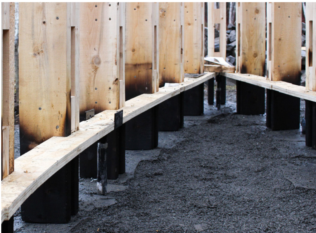
Figure 9. Structure en bois du cœur de gabion.
