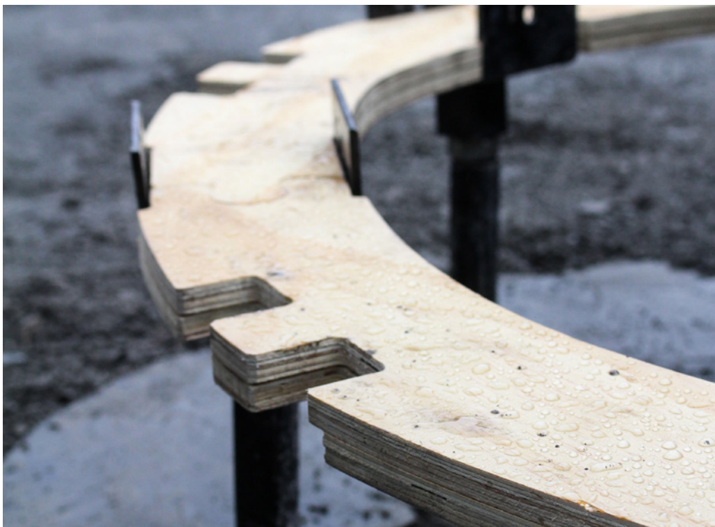
Figure B-6. Lisse basse posée sur les pieux
