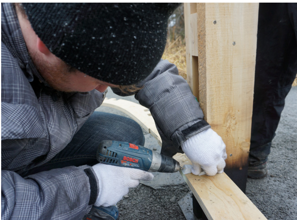
Figure 13. Préperçage dans la lisse basse à l'aide d'un gabarit
