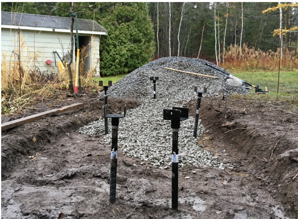
Figure 16. Site du pavillon avant la mise en place de la roche
