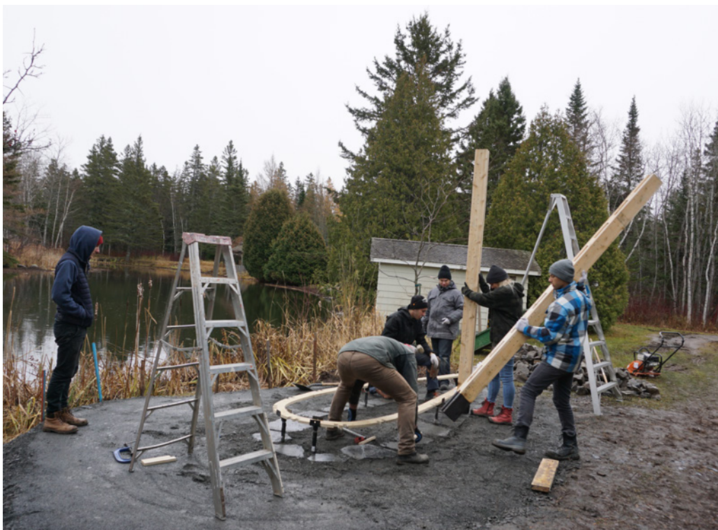
Figure 20. Assemblage des premières colonnes à la lisse basse
