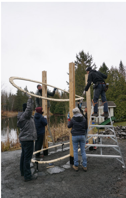
Figure 21. Préparation à l'imbrication de la lisse haute
