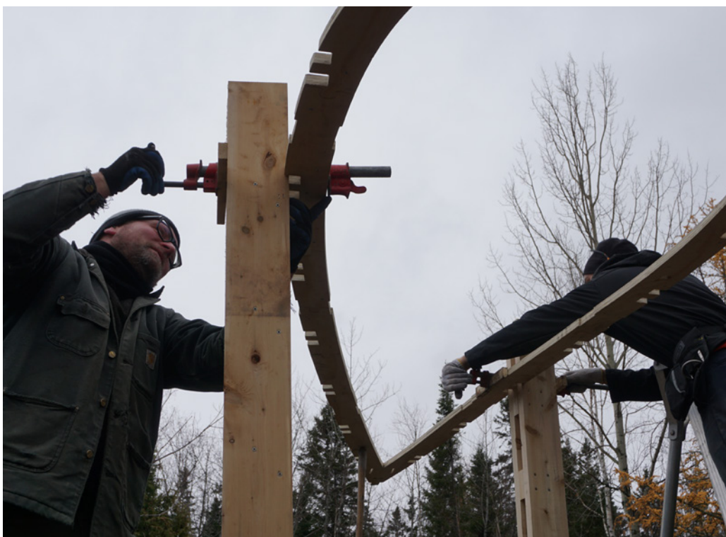
Figure 23. Assemblage des colonnes dans la lisse haute
