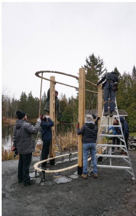
Figure 22. Imbrication de la lisse haute
