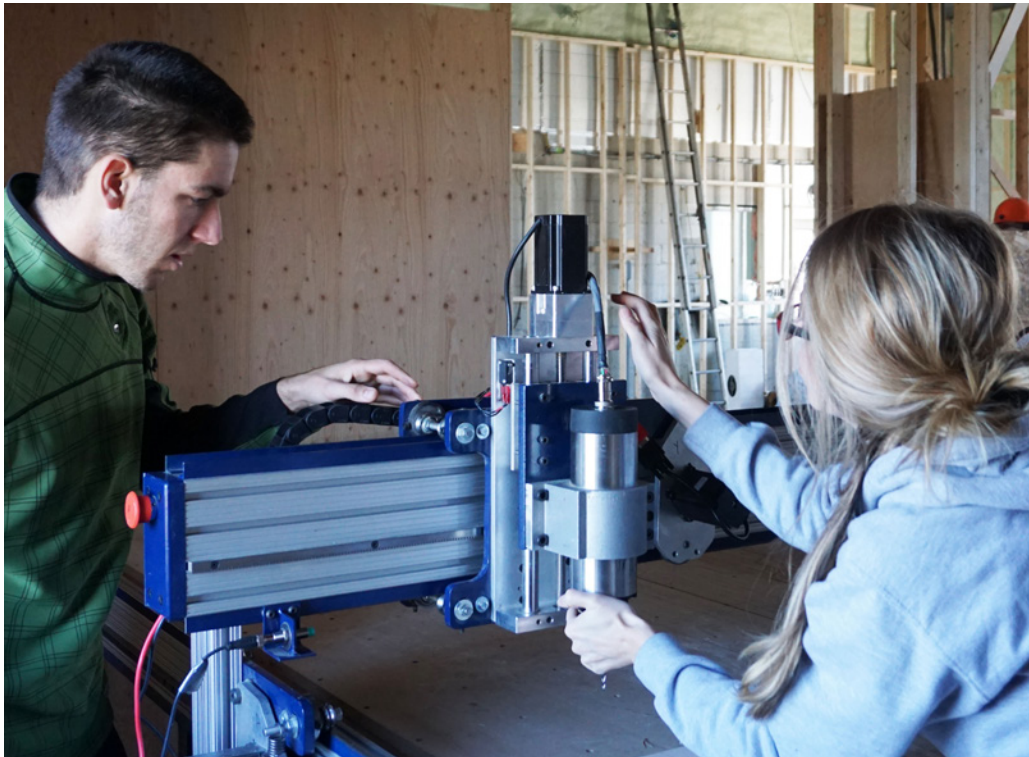
Figure B-3. Installation de la CNC en Gaspésie
