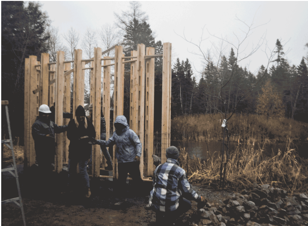
Figure 24. Travail à la chaîne pour le remplissage du cœur
