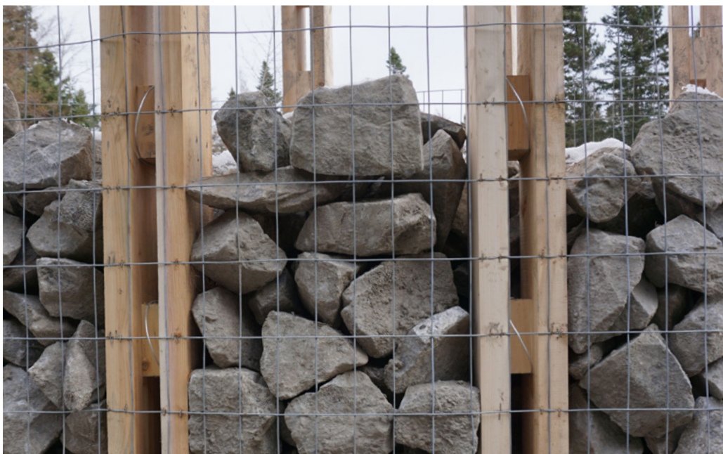
Figure 12. Pierres concassées du cœur en gabion
