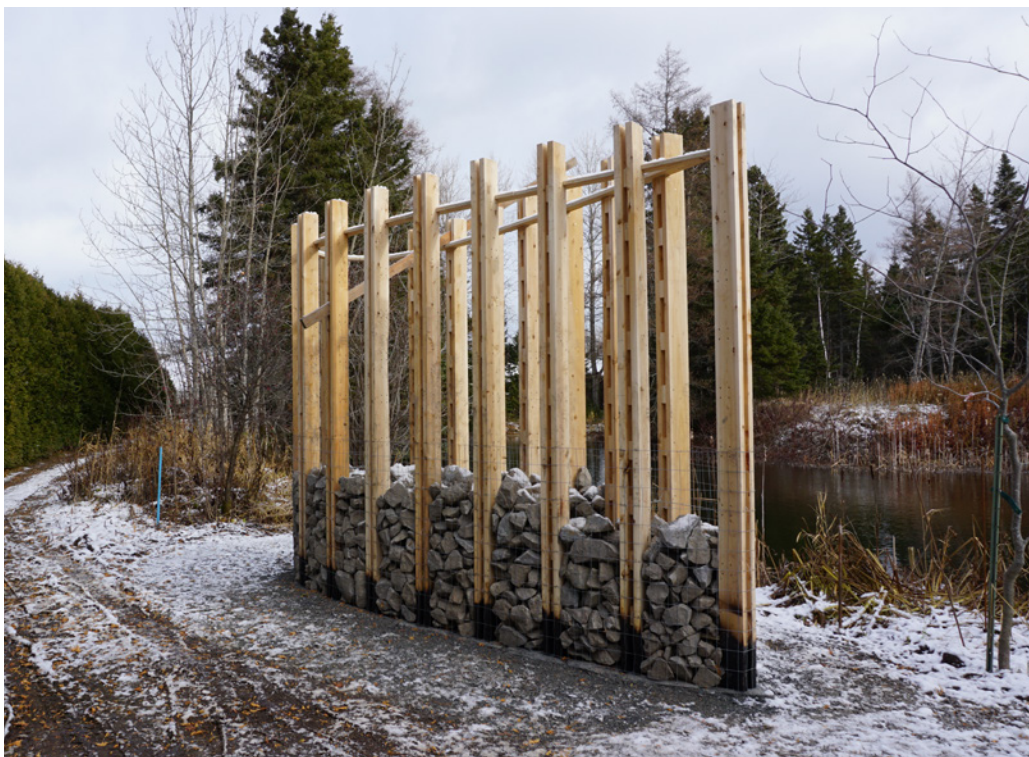
Figure 25. Avancement du pavillon le matin de la dernière journée de la deuxième phase de construction
