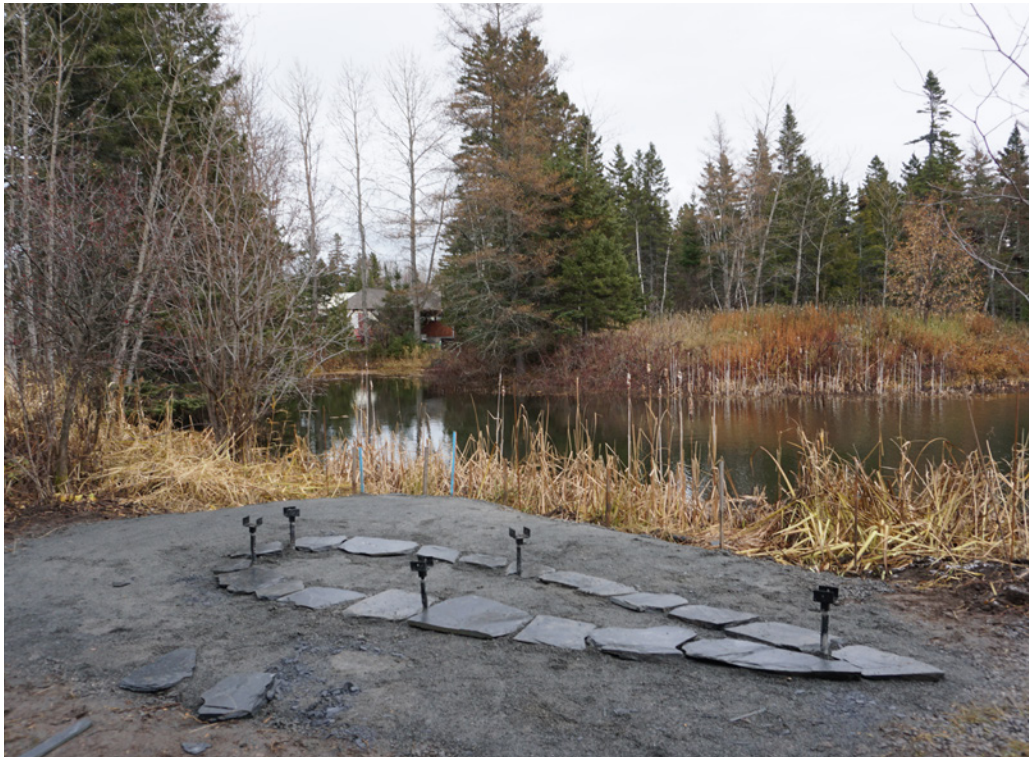
Figure 19. Ardoises et pieux prêts à recevoir la lisse sur le site
