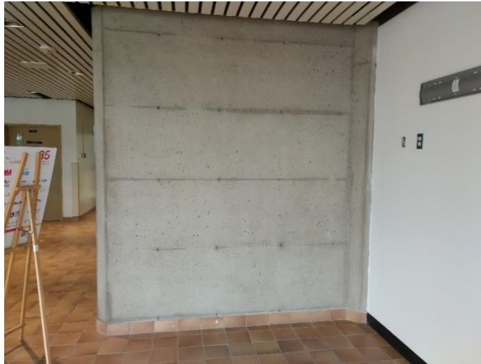
Figure 1 : Mur à œuvre
